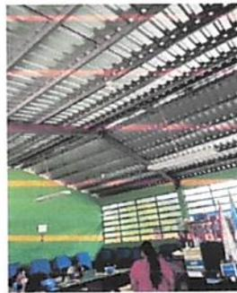
Foto 4: lámparas y focos instalados en dos salones de clases, pero sin funcionamiento por no estar la instalación eléctrica correcta
