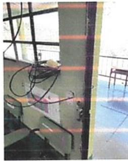
Foto 3: tomacorrientes y alambre instalados en un salón de clases pero sin poder funcionar por no estar la instalación eléctrica correcta
